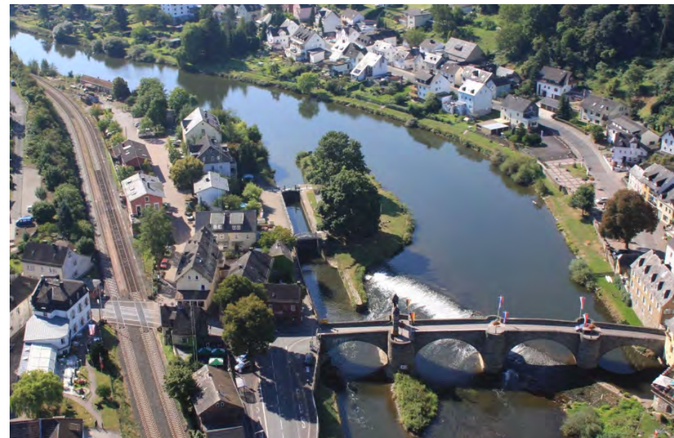
Luftbild Lahnschleuse Runkel
